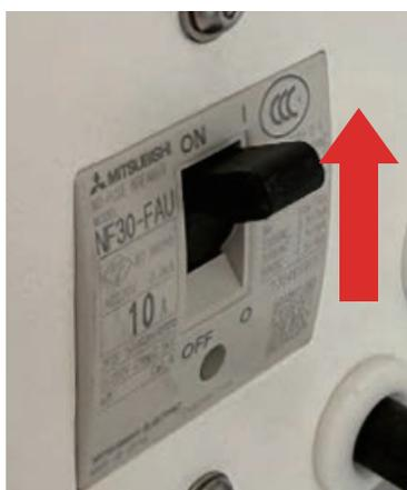
機器背面のブレーカースイッチのレバーを上に向けて電源を入れます。
