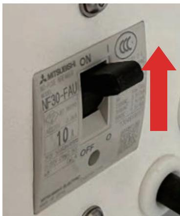
機器背面のブレーカースイッチのレバーを上に上げて電源を
